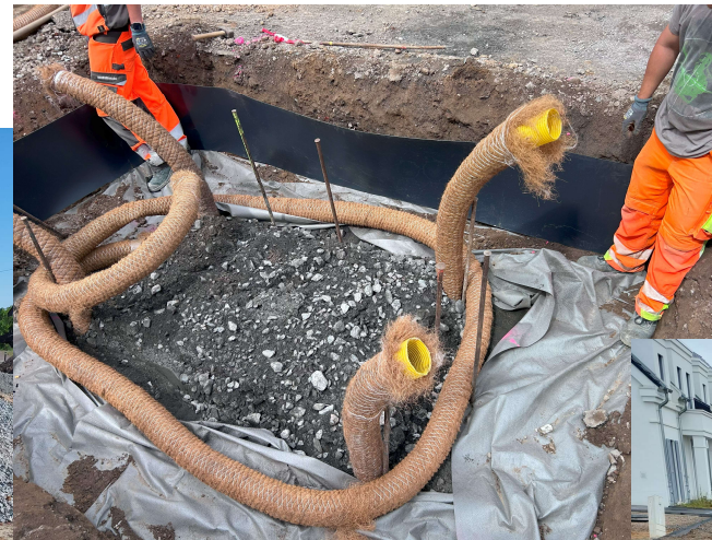
Einbau / Belüftung / Mischung mit Substrat
