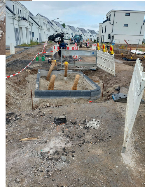
Setzen des Rahmens / Hochbord
