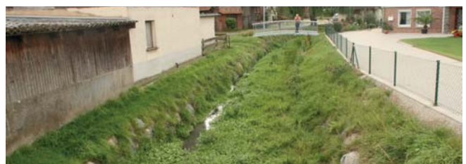
Berme in einer Ortschaft. Der eingeeengte Mittelwasserabfluss linksseitig sorgt mit hoher Schleppkraft für eine freie Rinne und die Berme ist bei Hochwasser Retentionsfläche, um Abflussspitzen zu kappen.
