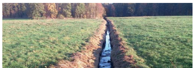
Die Uferrehne ist eine wallartige Erhöhung des Ufers. Sie vermindert die Wechselwirkung des Gewässers mit den umgebenden Flächen und entsteht bei kleinen Gewässern oft durch die Ablage von Räumgut. (Foto: H. Voermanek)
