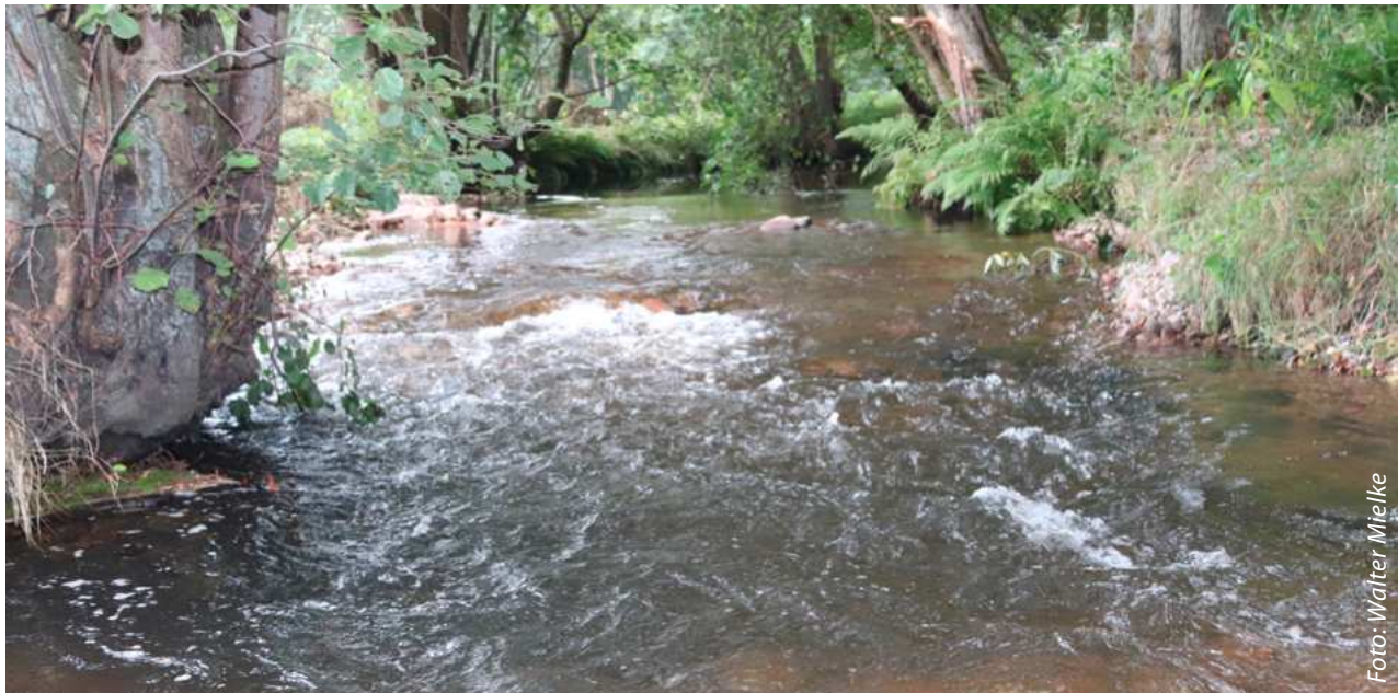
Diverses Strömungsbild nach Einbringung von Kies und Totholz als Strömungslenker
