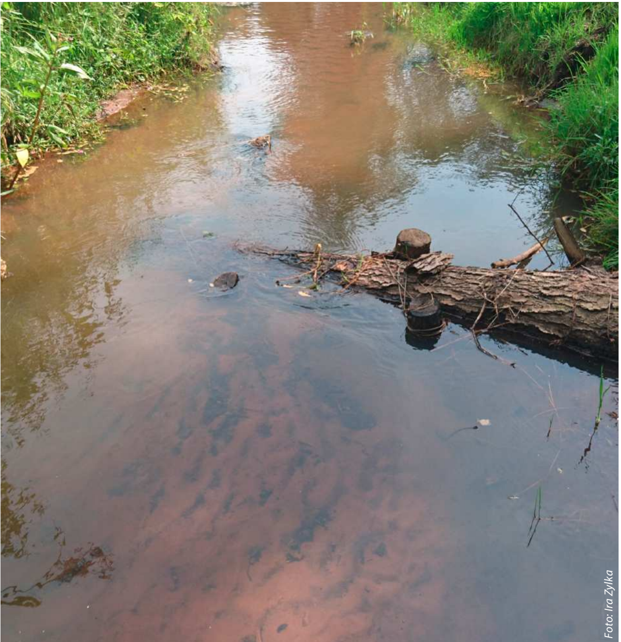
Eingebauter Erlenstamm mit Pfählen gesichert (2017)
