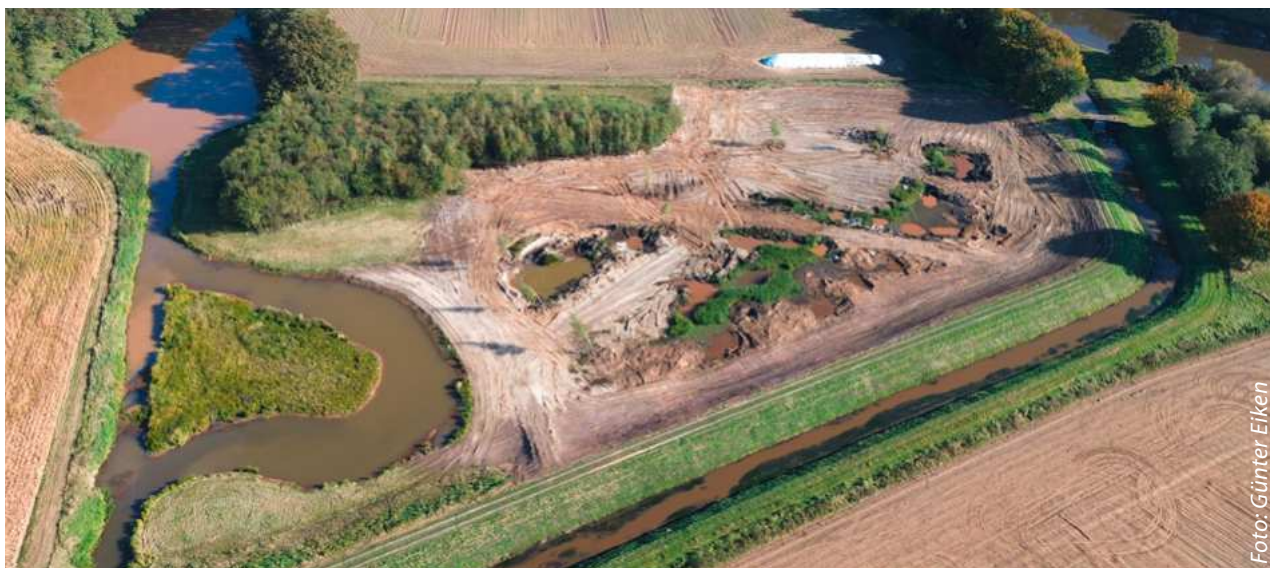
Luftaufnahme der Projektfläche von 2024, links oben entschlammtes Wörmer, links unten Mäanderschleife, rechts ehem. Spülfeld
