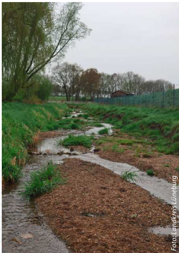
Die Maßnahmenstrecke nach Einbringung des Kieses in das neu ausgebagerte Bachbett
