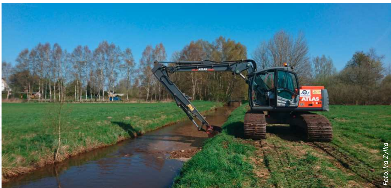
Einbau von Kiesbänken (2018)
