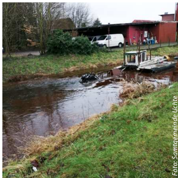
Saugboot bei der der Entschlammung oberhalb des Pfeifbringschen Sohlabsturzes
