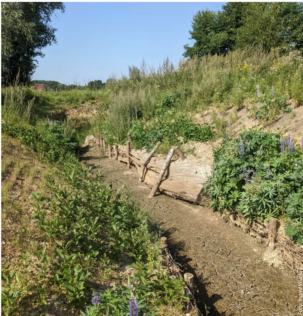
Ausgetrocknetes und mit Faschinen gesichertes Gerinne mit Initialbepflanzung
