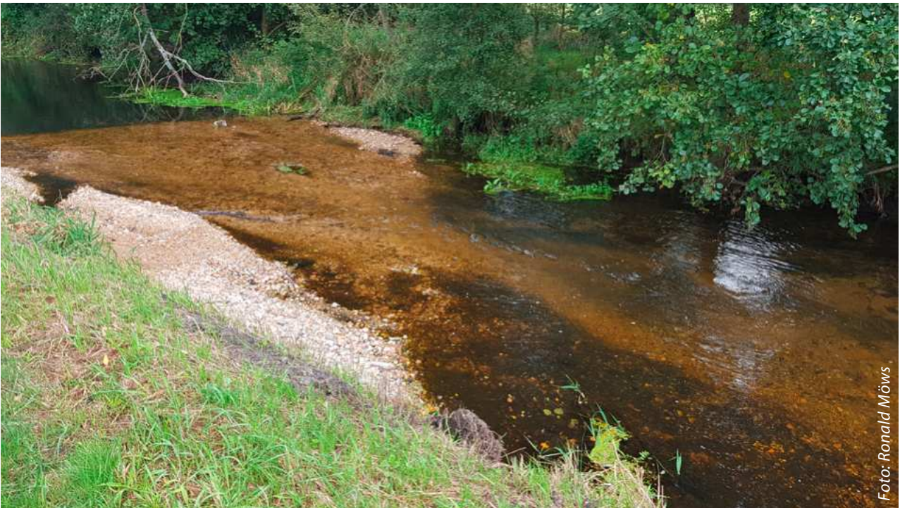
Eingebaute Kiesbank mit mittig verlaufender Niedrigwasserrinne
