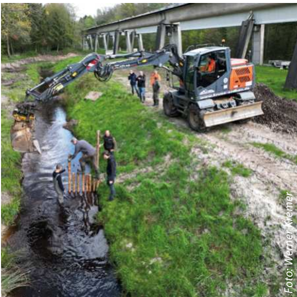
Einbau von Holzbunnen zur Verengung des Querschnitts und als Strömunglenker in das Gewässer
