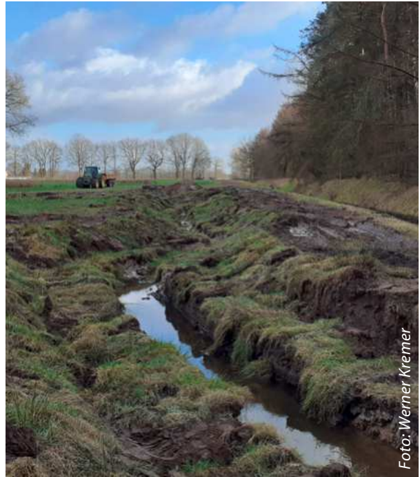
Fertigstellung des neuen Verlaufs am Schwartenberggraben (mit Wiederverwertung von Grassoden)
