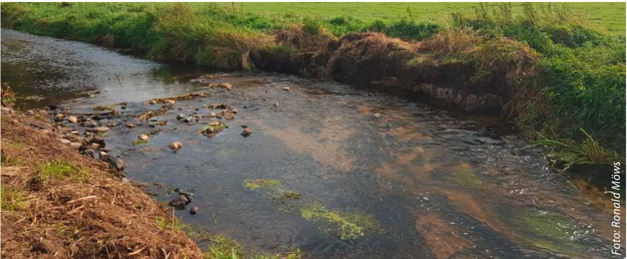
Vierte umgearbeitete Sohlswelle mit zusätzlicher Einbringung von Kies
