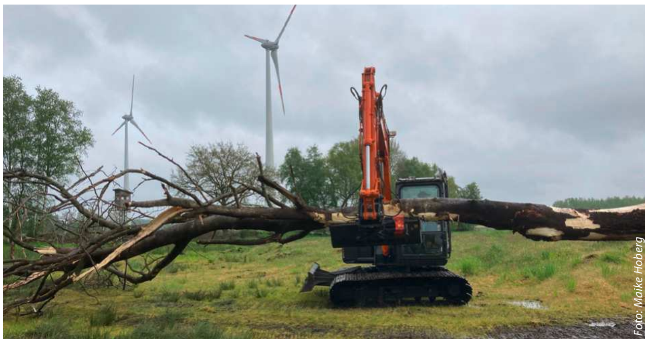
Anlieferung der Baumstämme zur Einbringung in den neuen Gewässerverlauf
