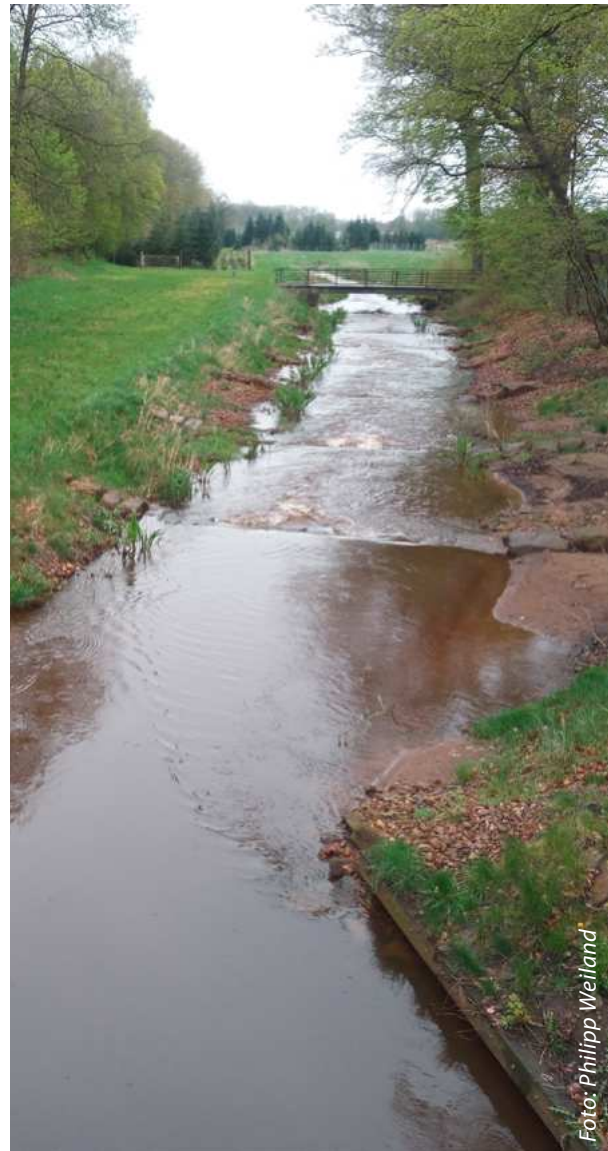
Umgebautes Pulternwehr zum Raugerinnebeckenpass
