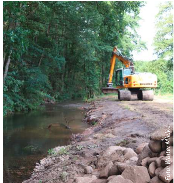
Einbringung von Lesesteinen mit Überkorn in den Bach
