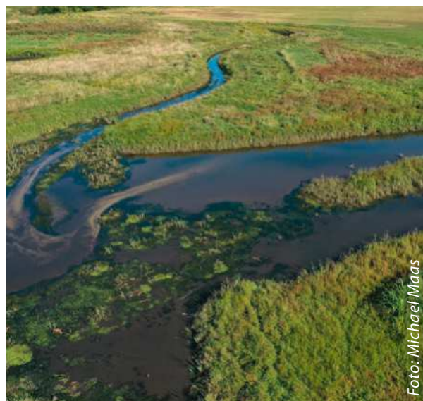
Luftbild der fertig gestellten Wattfläche (nördlicher Maßnahmenteil)
