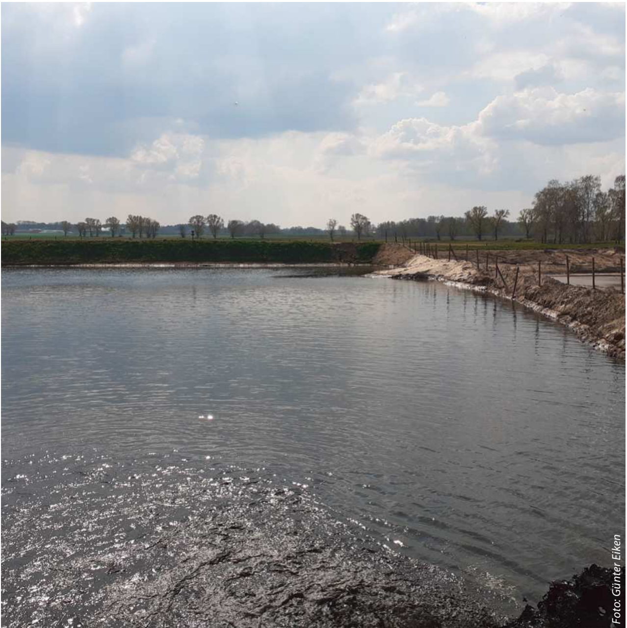
Spülfläche welche zur Entwässerung und Mineralisierung des abgesaugten Schlammes diente (Folgenutzung: Auwaldentwicklung)
