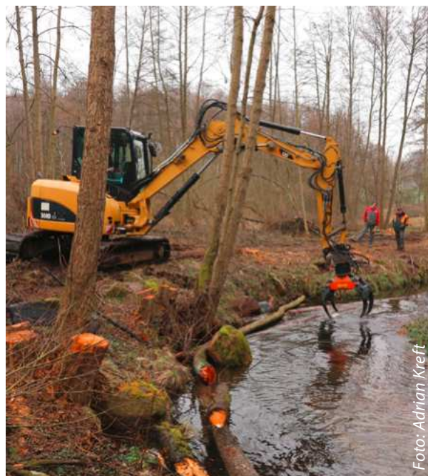
Einbau von Erlenstämmen aus aufgelichteten Uferbereichen
