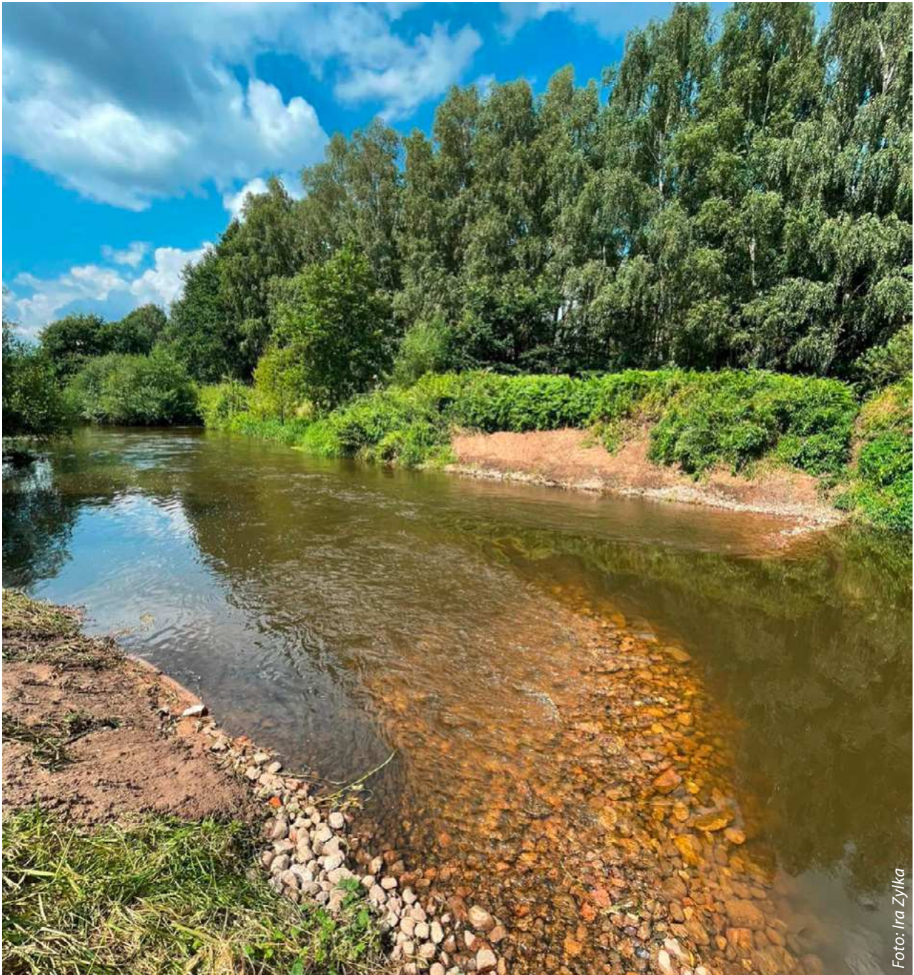
Erste 2021 eingebaute Kiesbank mit stromabwärts abnehmender Korngröße
