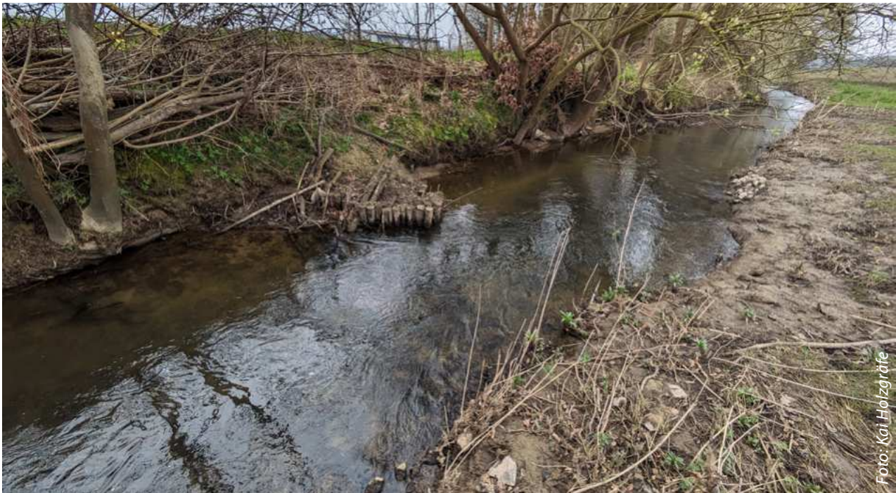
Initiierung der Eigendynamik im Altverlauf durch eingebaute Dreiecksbuhnen
