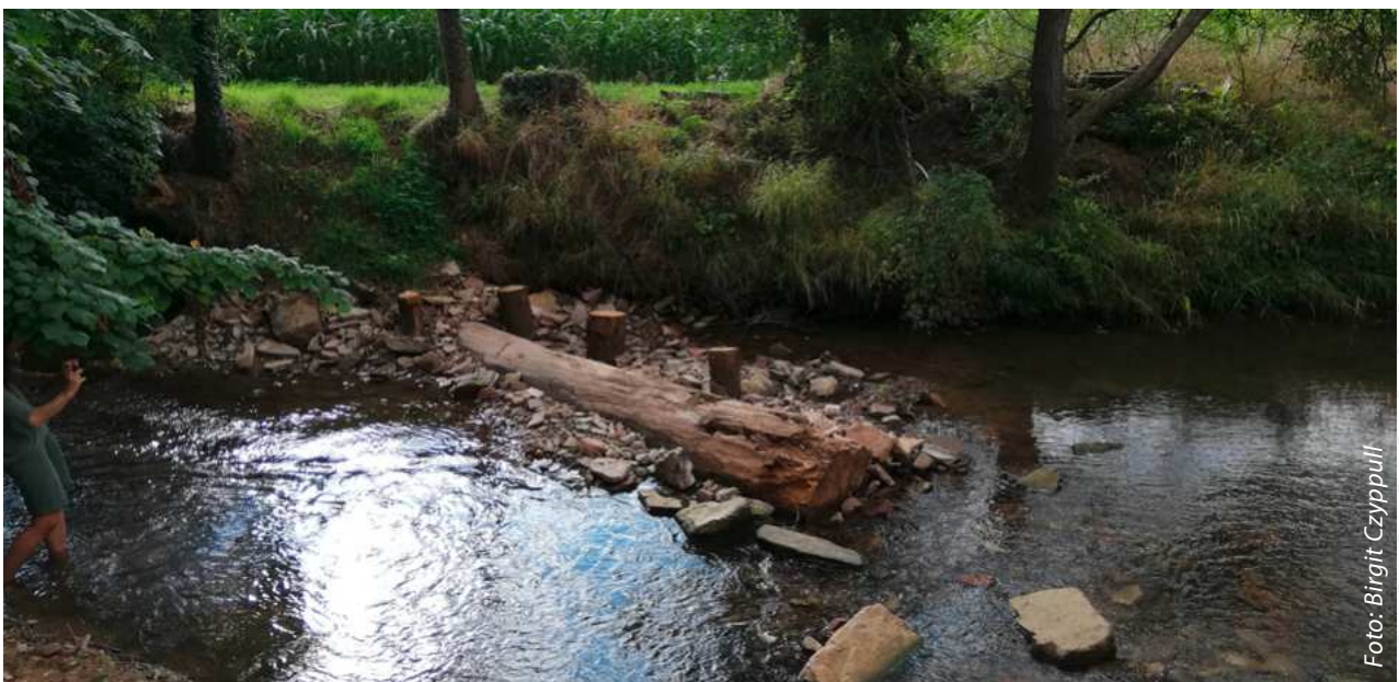
Abgrabungsbereich 1 mit Strömungsenker aus Stammholz nach Maßnahmenumsetzung Bild linke Seite: Abgrabungsbereich 2 mit Strömungsenker aus Stammholz nach Maßnahmenumsetzung
