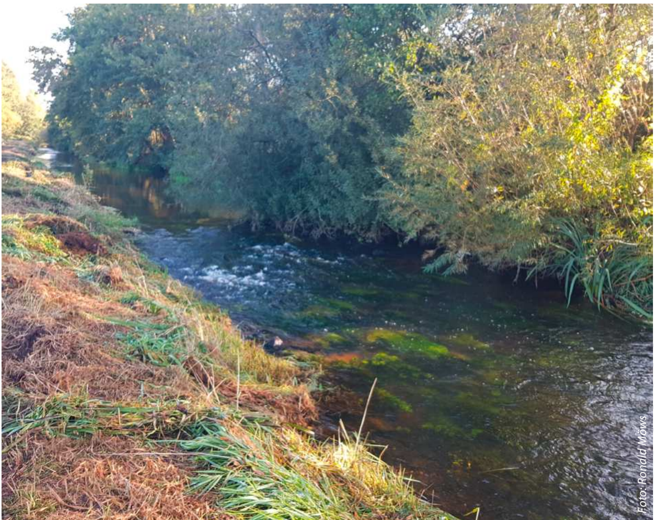
Erste Sohlschwelle, vor Maßnahmenumsetzung
