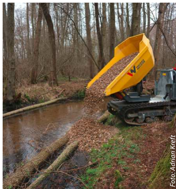
Kies wurde mit kleinem bodenschonendem Kettendumper eingebracht
