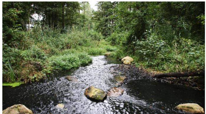
Funktionsfähigkeit besonders auf eine ausgeprägte Breiten- und Tiefenvarianz sowie Strömungsdiversität geachtet. Mit Altarmanbindung und der Herstellung des neuen Gewässerabschnitts ergibt sich eine Laufverlängerung von ca. 300 m. Des Weiteren wurde der vorhandene Schleusengraben ausgebaut und im Bereich der alten Mühle strukturreich gestaltet.
